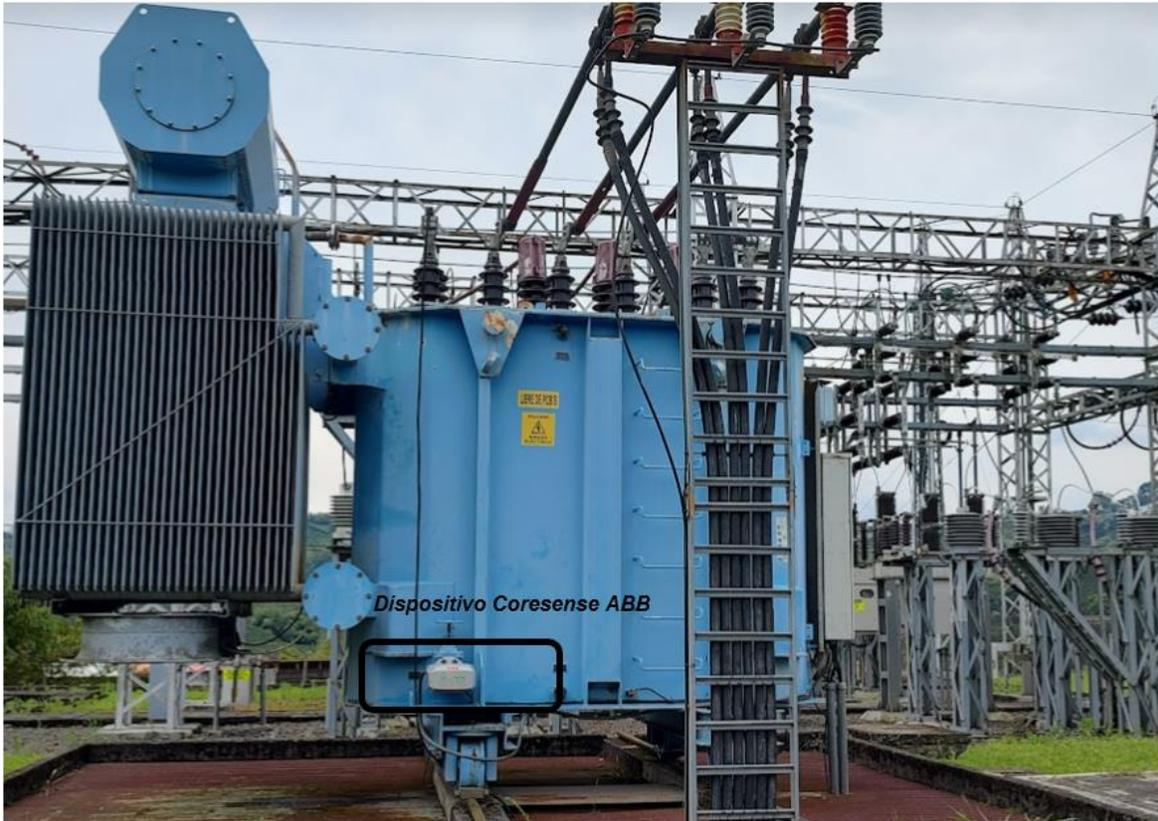
*Figura 22. Dispositivo Coresense transformador de potencia subestación CHEC. Fuente propia.*
