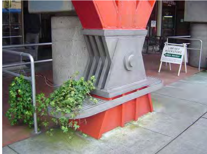
DETALLE DE LA BASE DEL EDIFICIO DE LA FOTO ANTERIOR (LOS PERNOS ESTÁN SOMETIDOS A CORTE)
