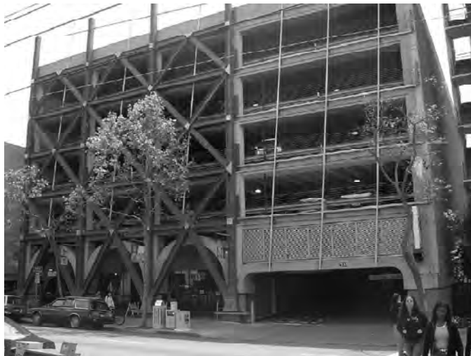
EDIFICIO REFORZADO CONTRA SISMOS. BERKELEY, CALIFORNIA 2005
