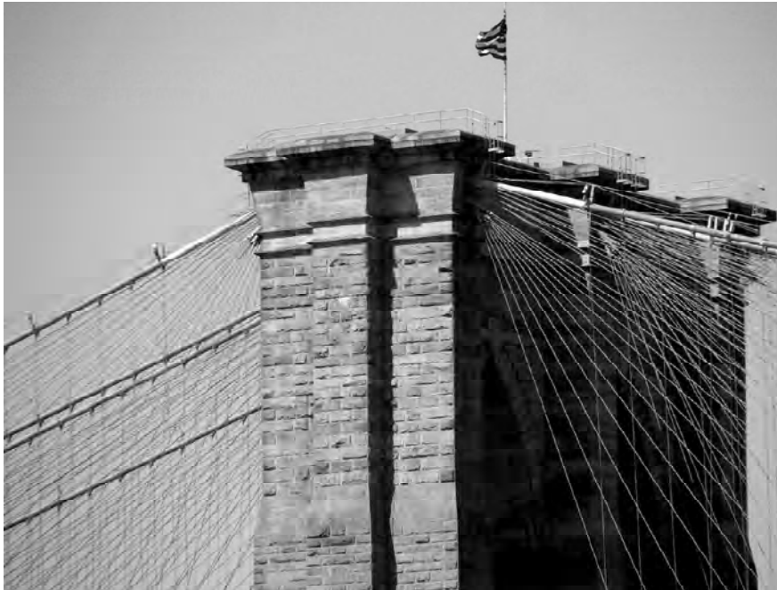
CABLES SOMETIDOS A TENSIÓN. PUENTE DE BROOKLYN, NUEVA YORK, 2005
