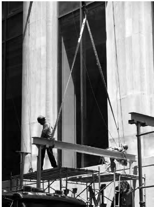
CONSTRUCCIÓN METÁLICA, NUEVA YORK, 2005
