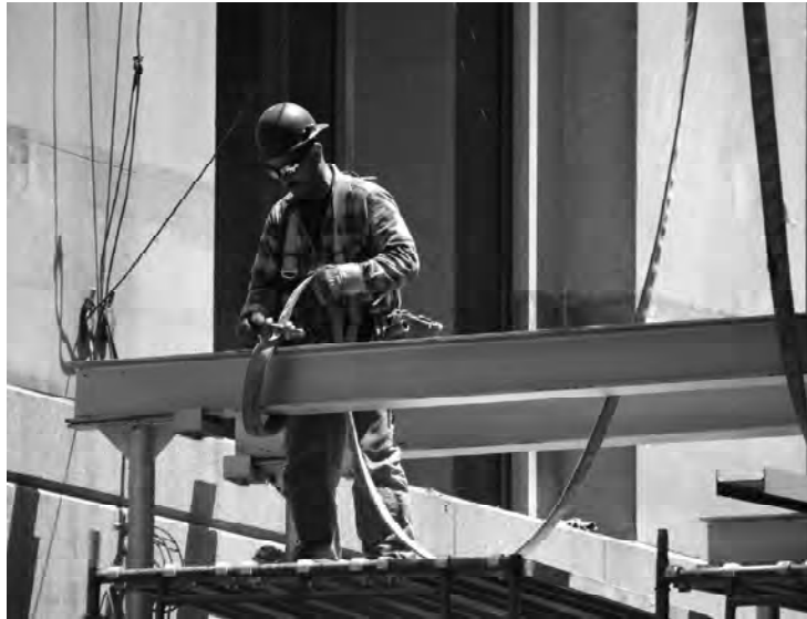
CONSTRUCCIÓN METÁLICA EN NUEVA YORK (EE.UU.) 2005
