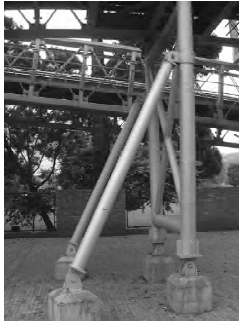
PUENTE PEATONAL, BOGOTÁ, 2005
